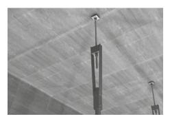
Stufenlos verstellbare Aufhängevorrichtung aus feuerverzinktem Stahl.
