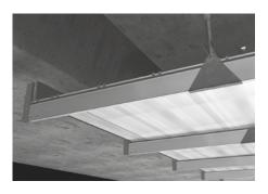
Flächengerüstträger werden am Betonkörper befestigt, abhubsichere Aluminiumbeläge mit Klauen garantieren eine schnelle Montage.
