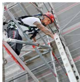
Titelseite Baustelle Kantonsspital GR
