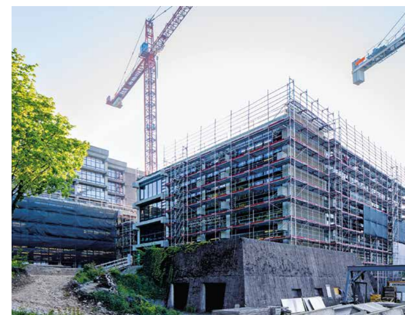
Testphase für das schwarze Sonnenschutznetz, das während der Sanierung die Storen ersetzen wird.
