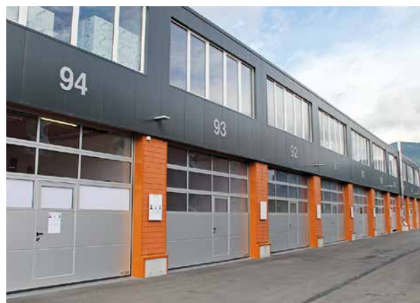
Beim Bau dieser Büroboxen haben Gaille Construction und Roth Gerüste eng zusammengearbeitet.
