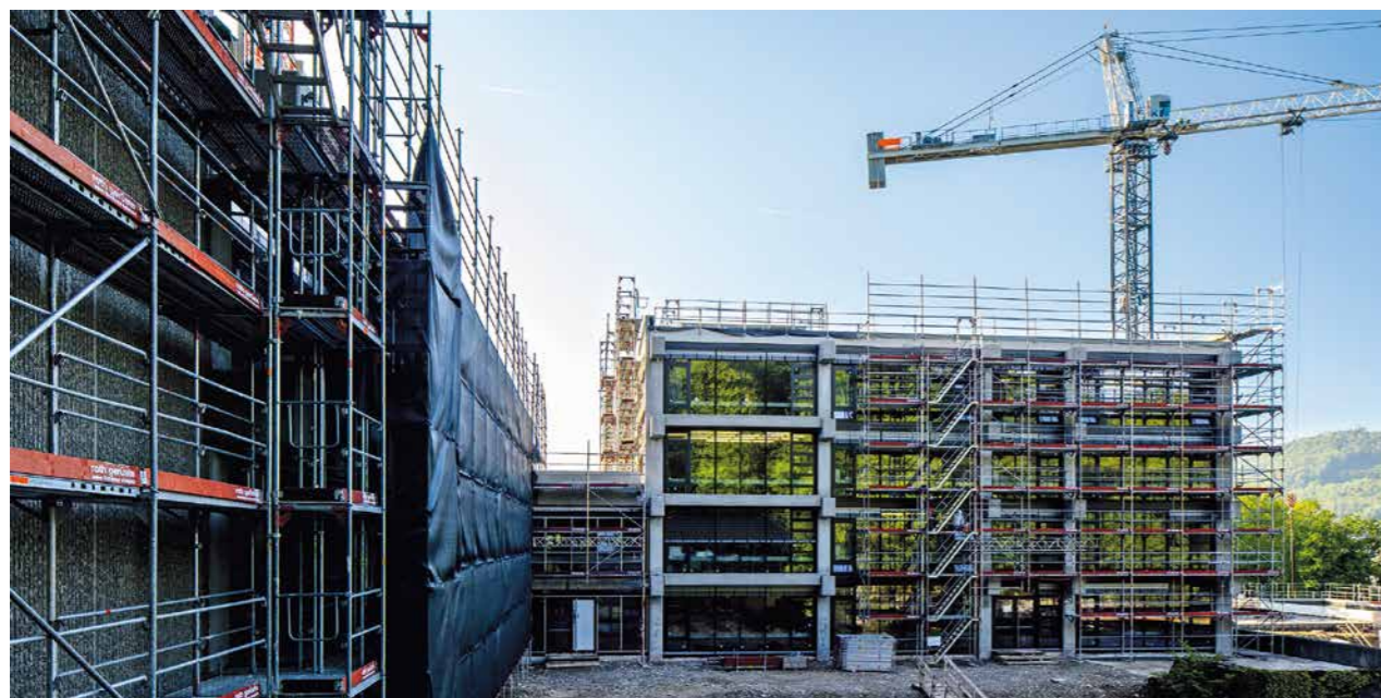
Une flexibilité signée Roth Echafaudages: pour la visite du maître d'ouvrage, une partie de l'échafaudage a été démontée. La sécurité reste garantie.
