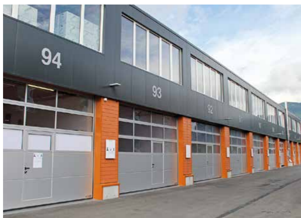
La construction de ces box a bénéficié de l'étroite collaboration entre Gaille Construction et Roth Echafaudages.
