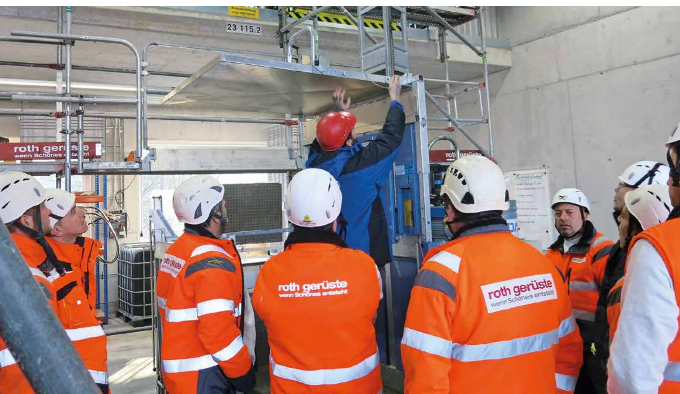
Comment installer et dépanner ascenseurs et monte-charge? Des techniques présentées lors des journées des monteurs.
