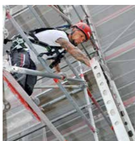
En couverture Chantier de l'hôpital cantonal des Grisons
